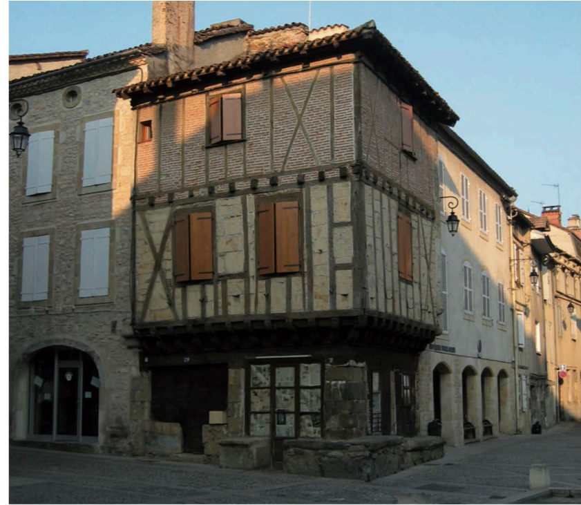
Sur un angle de la place de Mercadial à Saint-Céré, les boutiques d'une maison du XV e conserve ses étais de pierre.
