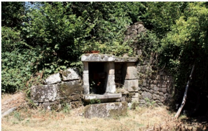
Puits construit en granit et intégré dans la montée d'une grange-étable
