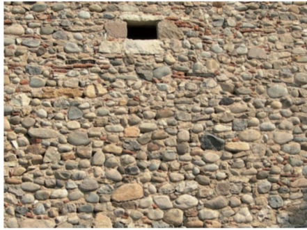
Maçonnerie en galets à La Serre (Girac)
